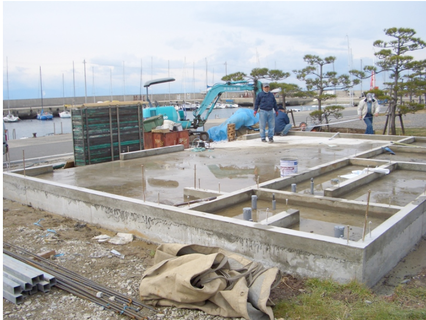
↑ 型枠撤去風景
