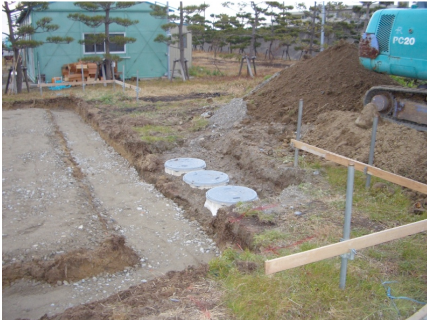
↑ 浄化槽埋め戻し風景
