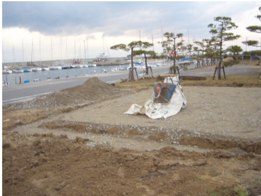
↑ ベタ基礎整地転圧風景
