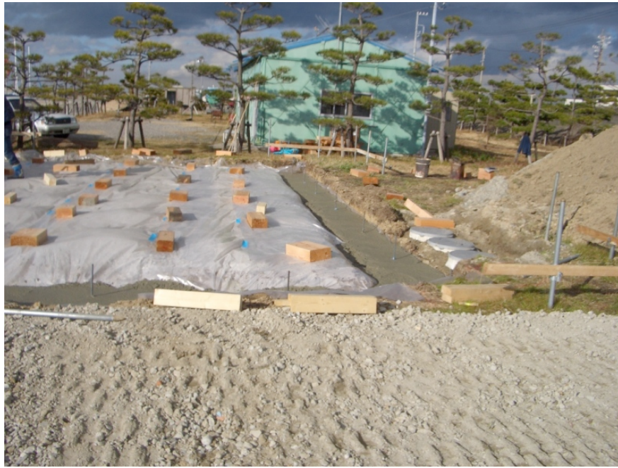
↑ ベタ基礎防湿シート引き捨てコンクリート打ち風景
