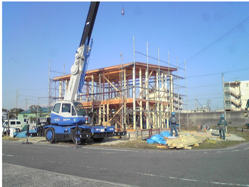
↑ 建方屋根下地完了風景
