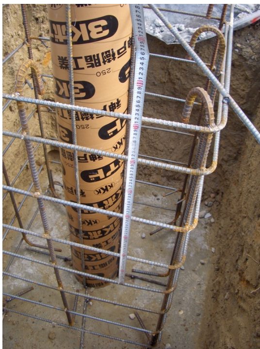
↑ 基礎立上がりコンクリート打ち風景
