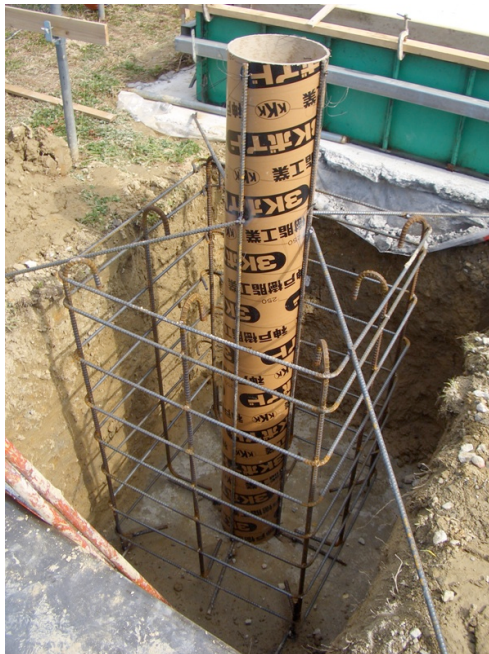
↑ ポール基礎配筋風景
