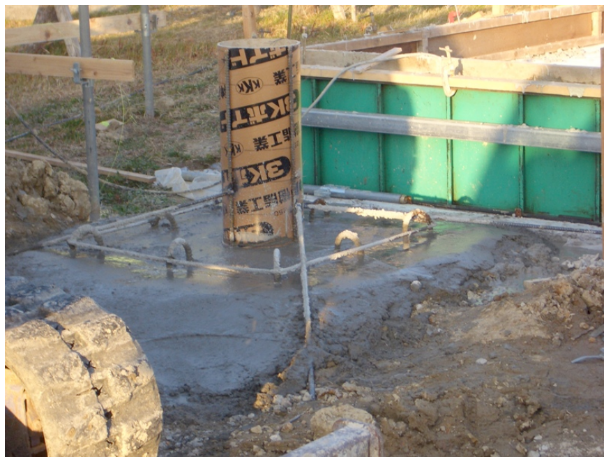
↑ ポール基礎コンクリート打ち風景
