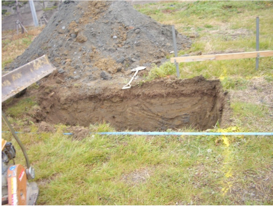
↑ 浄化槽掘削風景
