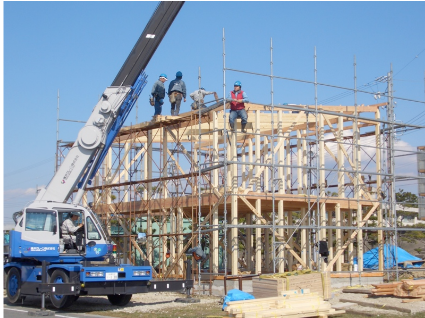
↑ 建方軸組完了風景
