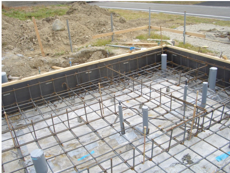
↑ 同上先行給排水配管工風景
