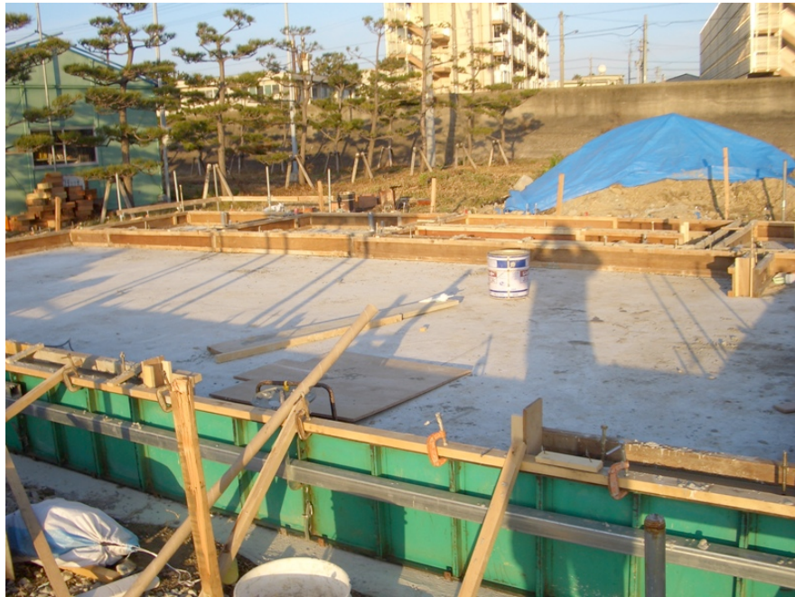
↑ 基礎立上がりコンクリート打ち風景
