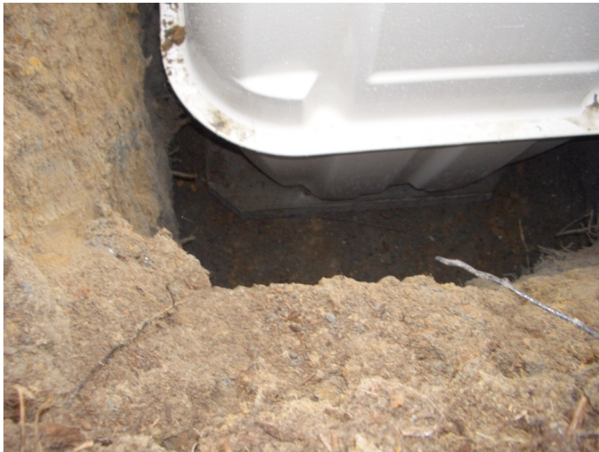
↑ 浄化槽据付風景
