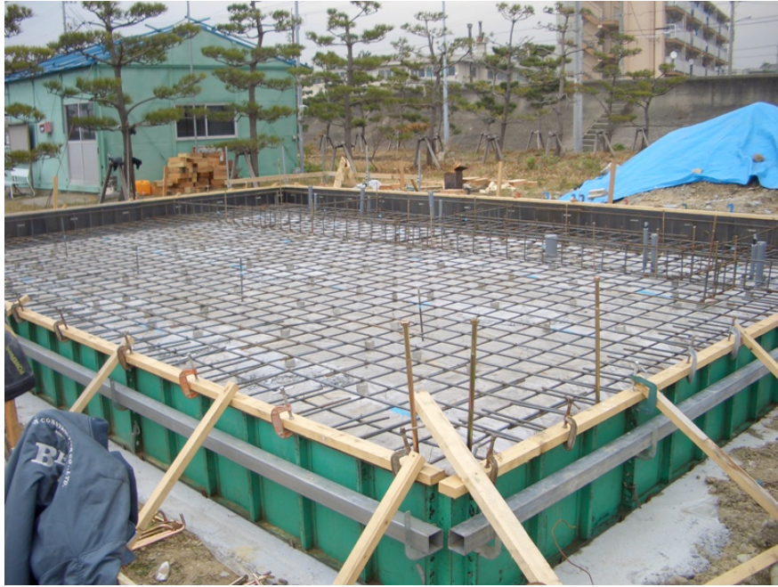
↑ ベタ基礎型枠鉄筋組風景
